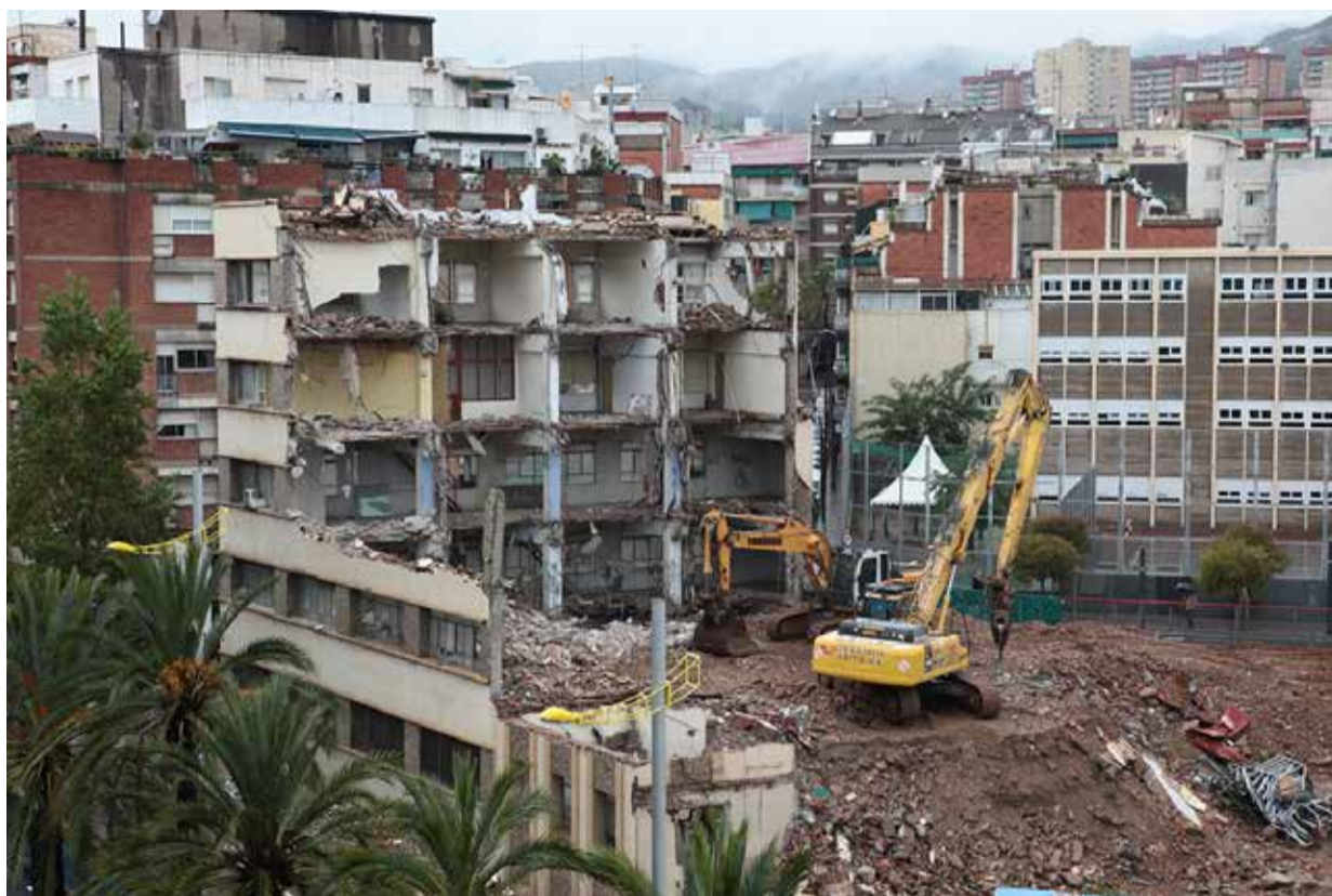
Enderroc de la fàbrica el 2009. Una reivindicació que va començar als anys 80. Manel Sala-9 Barris Imatge
