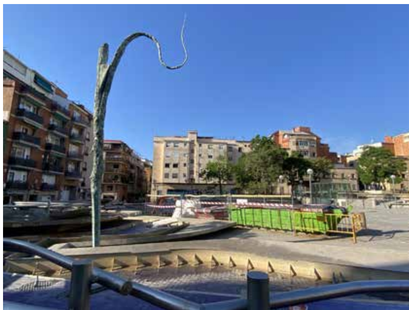
Obres a la plaça Àngel Pestaña, arreglaran les graderies?
